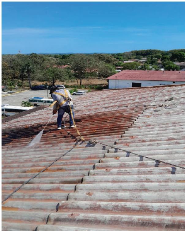
Trabajos de Reparación de Techo de la Extensión Universitaria de Chiriquí
