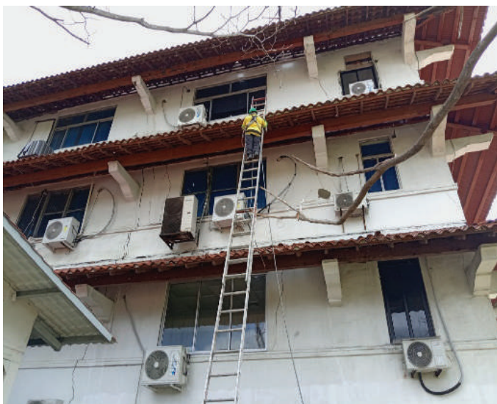
Renovación de Pintura de la Fachada Exterior de los Edificios de la seda
